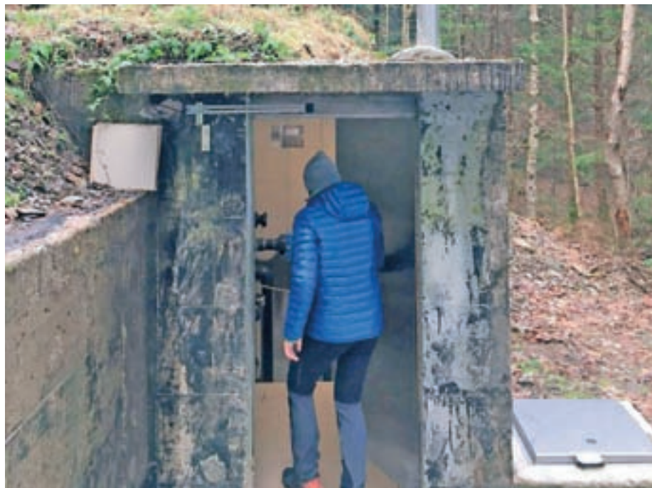
Vhod v vodovodni objekt
