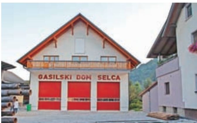
Gasilski dom v Selcih je pred kratkim dobil fasado.
