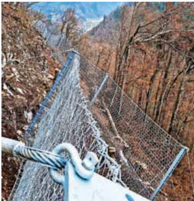
Tik pod zgornjimi skalnimi robovi so vgradili tri podajno-lovilne sisteme dolžine šestdeset metrov in višine pet metrov. / Foto: Eho Projekt
